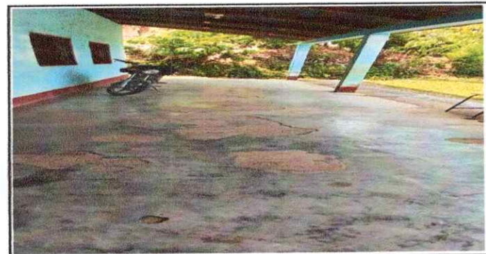
Foto 12: Se observa el Deterioro del Piso del Corredor de las Aulas.
