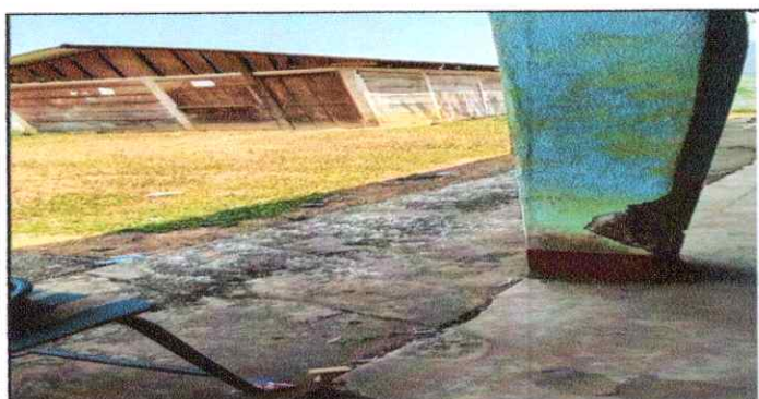
Foto 11: Se observa el Deterioro de la una de las columnas del Edificio Escolar.
